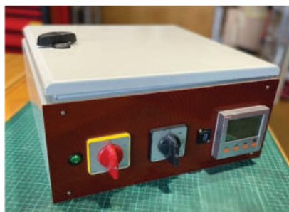
Obr. 1 Ovládací panel rozvaděče
